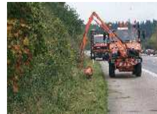
práce na ceste
