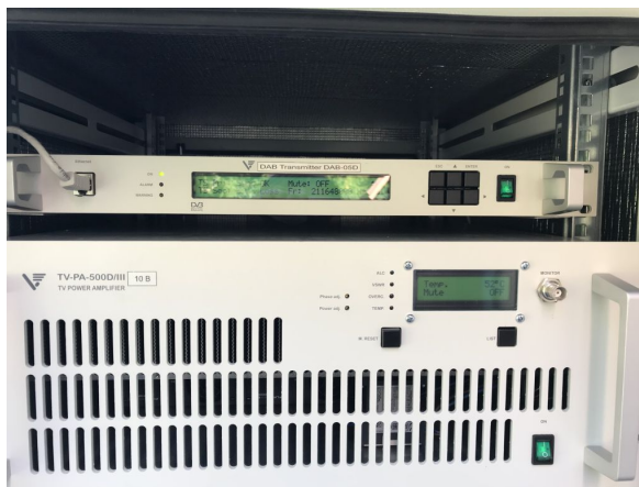
Obr. 5 – Modulátor T-DAB+ a koncový stupeň (v skrini na Panskom diele)
